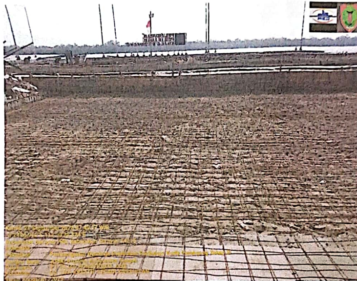
PEKERJAAN PERAKITAN PEMBESIAN DIREKSI KEET LAMA
