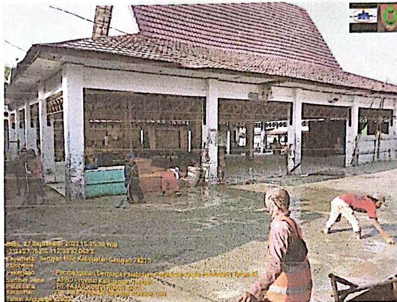
PEKERJAAN PENGECORAN JALAN AKSES MASUK KE DERMAGA
