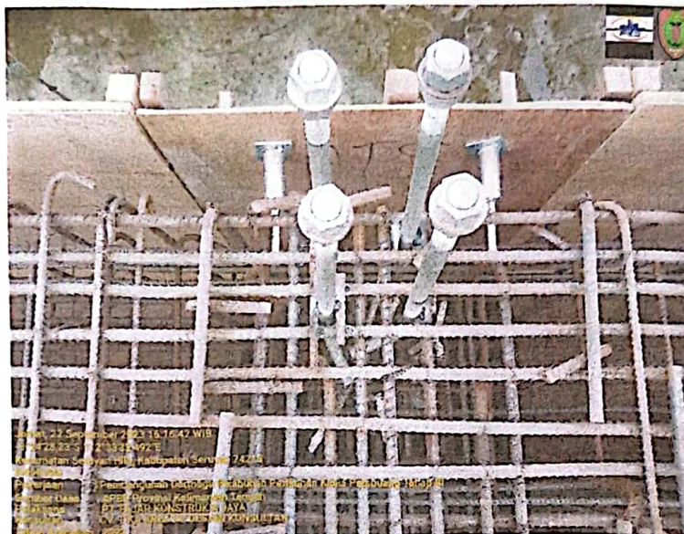
PEMASANGAN ANGKUR BOLLARD
