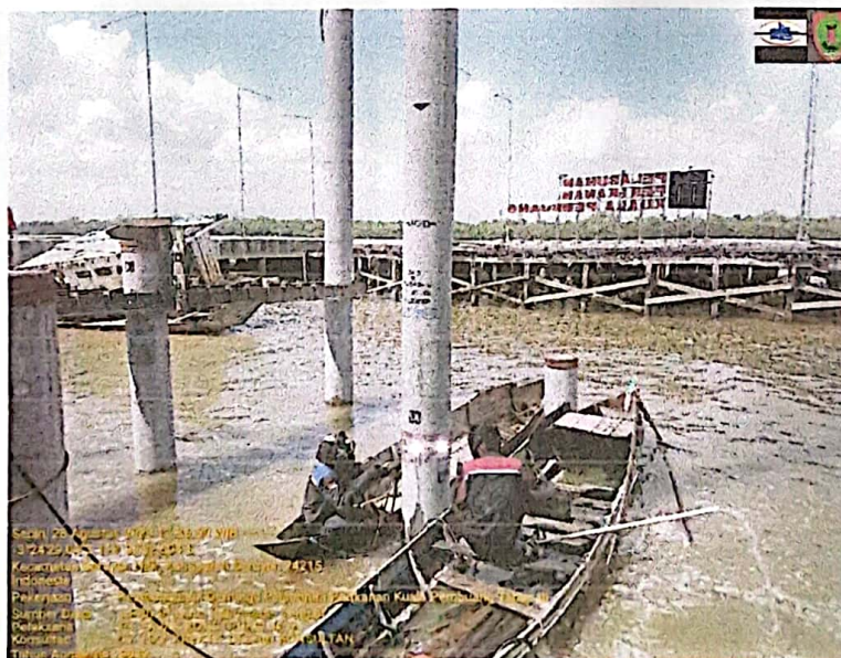
PEKERJAAN PENGELASAN SAMBUNGAN PLAT PADA TIANG
