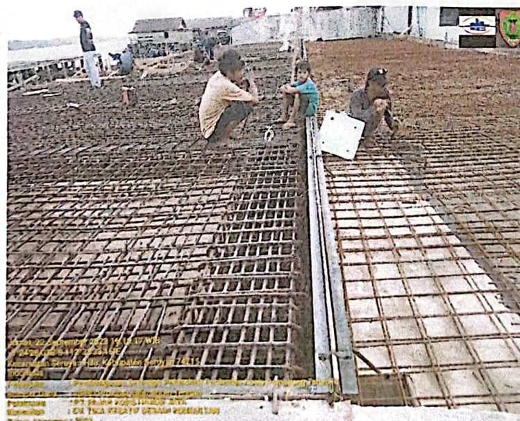
PEKERJAAN LAS PLAT SIKU 5.5 JOINT SAMBUNGAN
