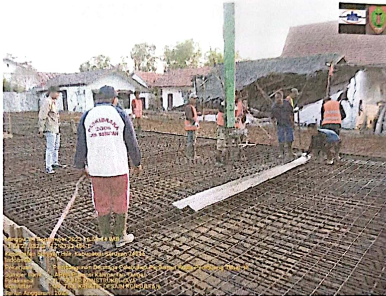
PEKERJAAN PENGECORAN BALOK, BALOK FENDER & LANTAI DERMAGA
