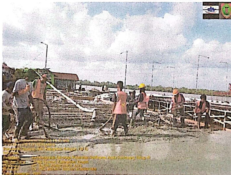
PEKERJAAN PENGECORAN BALOK, BALOK FENDER & LANTAI DERMAGA
