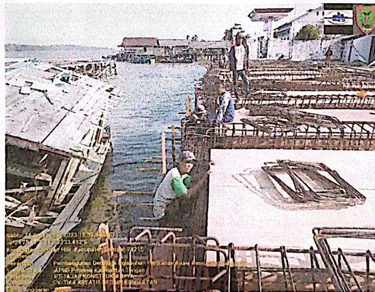
PEKERJAAN PERAKITAN PEMBESIAN FENDER
