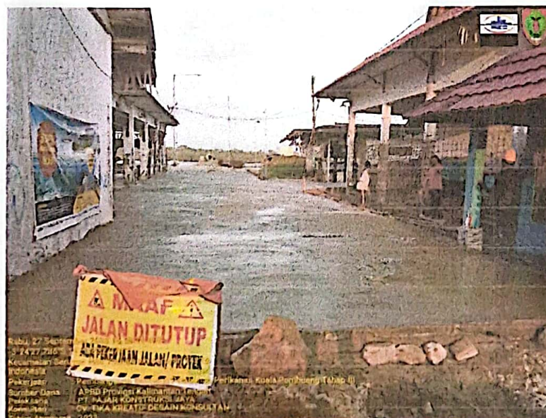
PEKERJAAN PENGECORAN JALAN AKSES MASUK KE DERMAGA
