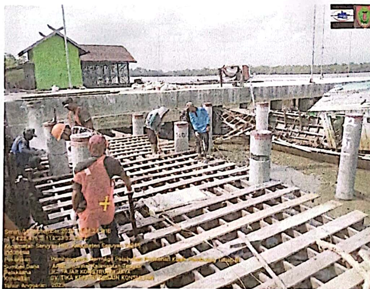
PEKERJAAN PEMOTONGAN TIANG SPON PILE
