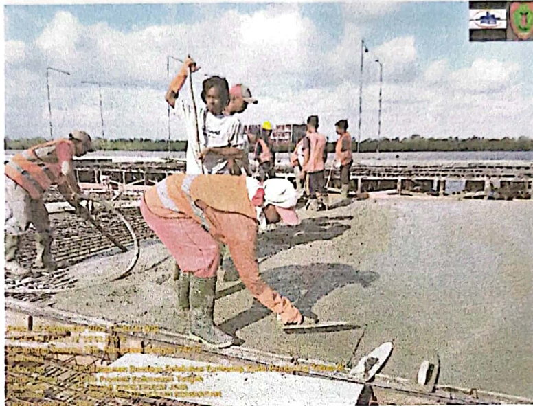
PEKERJAAN PENGECORAN LANTAI DERMAGA
