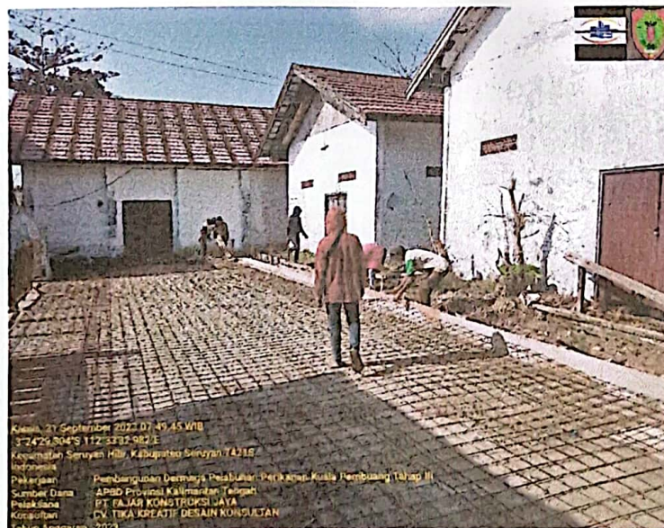
PEKERJAAN PERAKITAN PEMBESIAN JALAN AKSES KE SPBU
