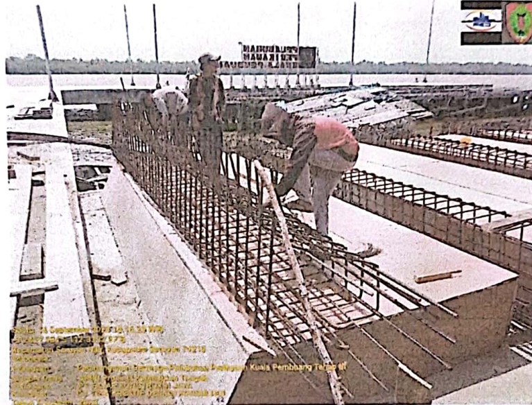
PEKERJAAN PERAKITAN PEMBESIAN BALOK
