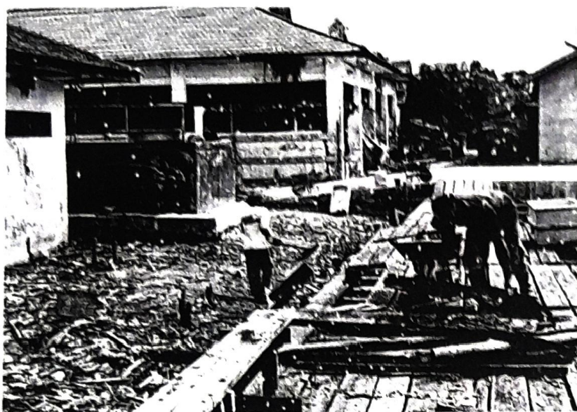
Pembersihan Lokasi dan Pembongkaran Bangunan Lama
