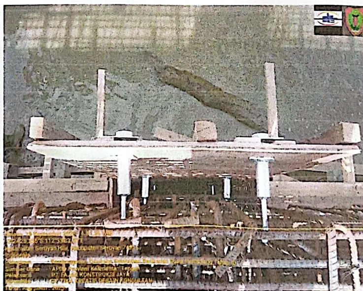
PEMASANGAN ANGKUR FENDER
